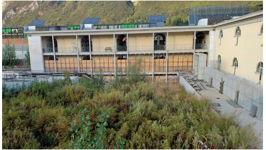
L'area sulla quale verrà costruito il giardino delle rimembranze
